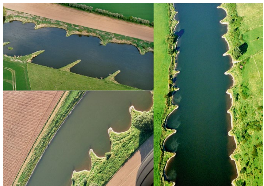
Bild 5: Bunnen über Bunnen, Längsdeckwerk dazwischen oder als selbständige Sicherung wie unten links
