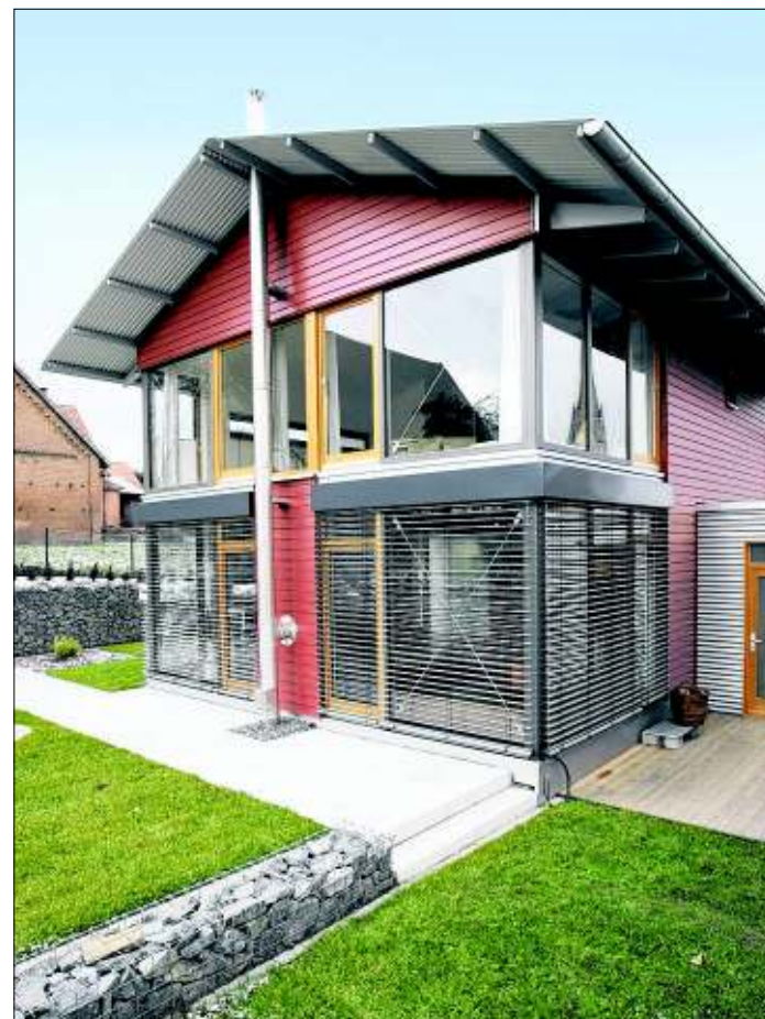
Das von Heino Heine entworfene Haus bezieht die Energie für Heizung und Warmwasser über einen Wärmetauscher aus dem nahen Mühlenbach in Kleinenbremen. Foto: pr
