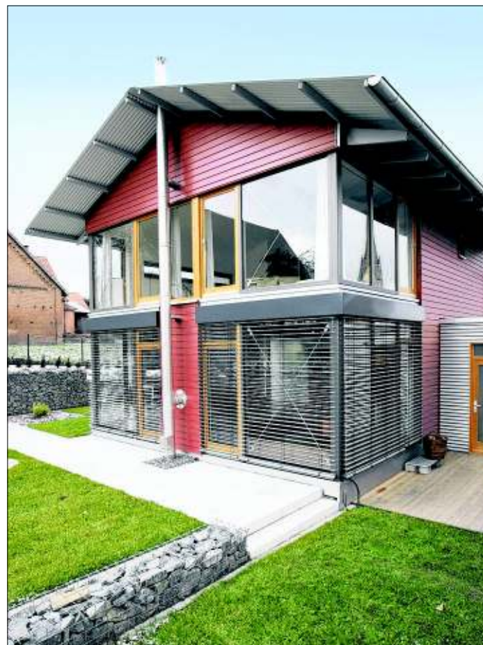
Das von Heino Heine entworfene Haus bezieht die Energie für Heizung und Warmwasser über einen Wärmetauscher aus dem nahen Mühlenbach in Kleinenbremen. Foto: pr
